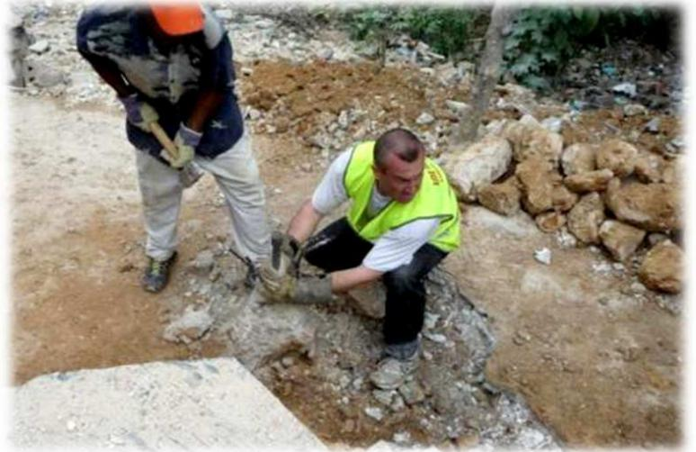
**Photo – Burin improvisé avec un ½ arbre de roue : attention les doigts !**
