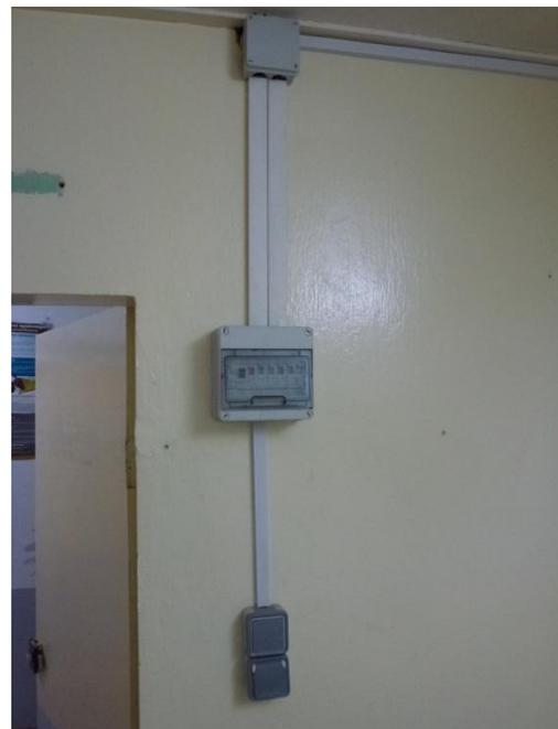
Le nouveau disjoncteur différentiel est posé, la boîte à fusible est posée, les fils sont tirés et les luminaires sont posés dans chaque salle du centre de soins.
