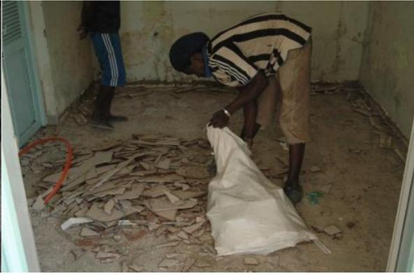
On retire l'ancien carrelage afin d'encastrer les réseaux. Les murs sont décrépés et préparés à recevoir la faïence. La nouvelle faïence est posée. Ainsi que les carreaux au sol. On laisse l'emplacement afin d'ajuster le fauteuil de dentiste dans la pièce.
