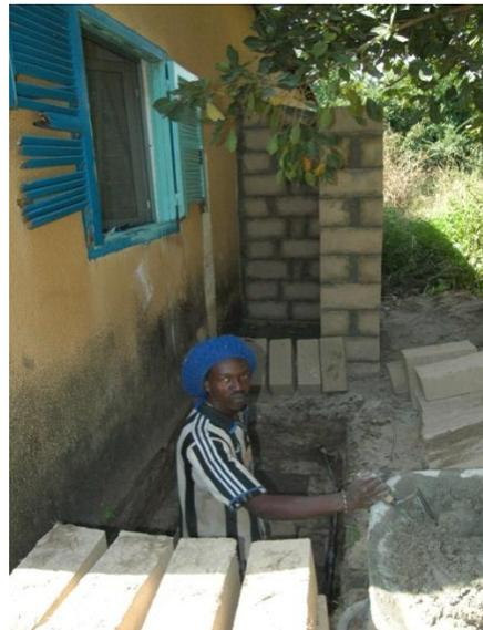
Malang, le maçon creuse la fosse septique et de filtration, tout en construisant le local technique qui devra recevoir le compresseur et l'aspirateur. Les faïences et carreaux achetés à Ziguinchor sont livrés par « taxi sept places ».
